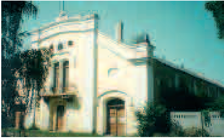
Die Reithalle in Kisbér ist so heute noch zu sehen.
