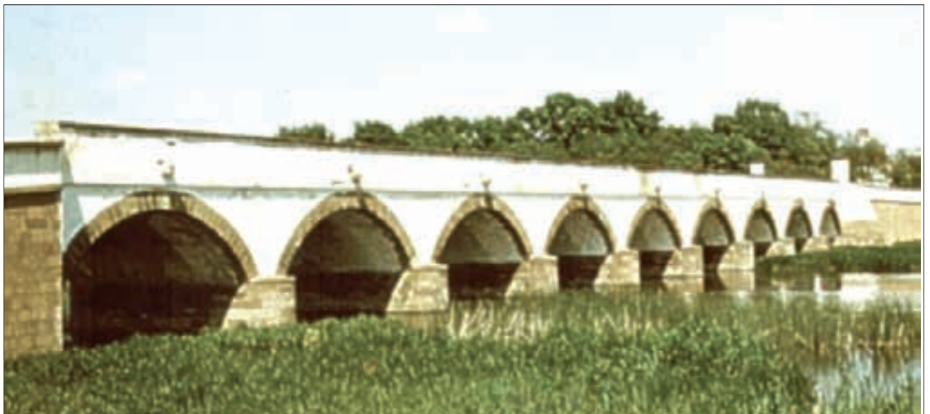
Die Neunlöcher-Brücke, erbaut von 1827 bis 1833 durch Ferenc Popolay, ist die längste ungarische Steinbrücke und überquert den Hortobágyfluss.
